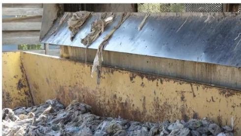
Une accumulation de lingettes usagées à la sortie d'une canalisation d'une station d'épuration près de Mulhouse. (JEAN-FRANÇOIS FREY / MAXPPP)
